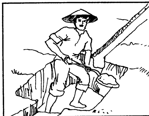
Gambar 34. Pada saluran drainase dibuat penangkap tanah yang terkikis oleh hujan, dengan ukuran dalam 1 meter, lebar 1 meter dan panjang 1 meter.
